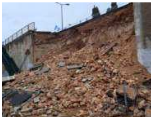
הקירות כמטרד: קריסת קיר תמך ברחוב יד לבנים בחיפה ב-2023, שיקומו עדיין בתהליך. מקור: 'יפה נוף', 2023
