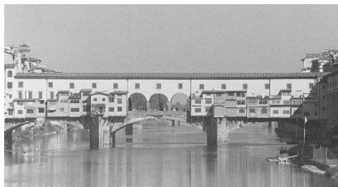
Ponte Vecchio, Florence, photo: Theresa Flanigan, 2008 טשטוש גבולות השימושים: צורך תקופתי הוביל לשילוב מסחר ותנועה
