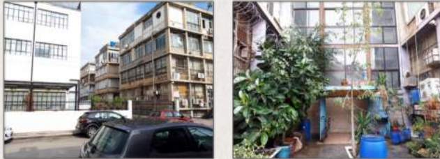
בניין משרדים ישן ברחוב בן אביגדור שעבר הסבה למגורים צולם ע"י הכותב
